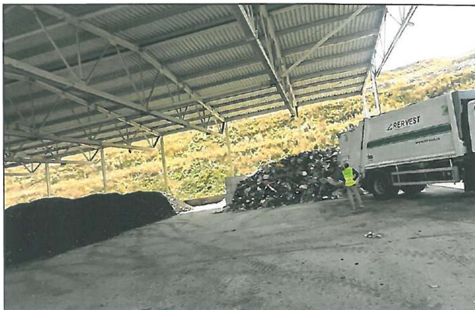
Foto 2 – Zona de depozitare sticlă sub șopronul de rafinare și maturare-TMB (Sursa: arhiva proprie)
