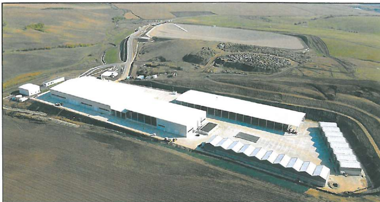
Figură 3 – Imagine de ansamblu a instalației IPPC – CMID Galda de Jos
