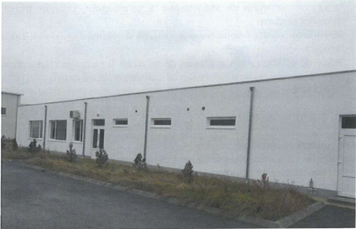
Zona administrativă a CMID Galda de Jos
